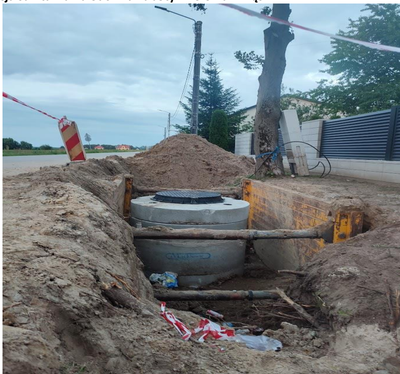
Zdjęcie 1. Kanalizacja sanitarna na odcinku Lubotyń-Kolonia - Rząśnik
