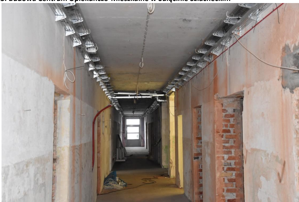
Zdjęcie 15. Budowa Centrum Opiekuńczo-Mieszkalne w Sulęcinie Szlacheckim
