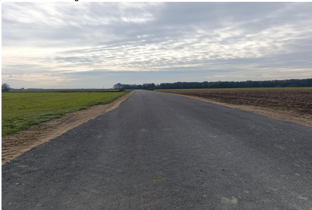
Zdjęcie 7. Przebudowa drogi w Kosewie
