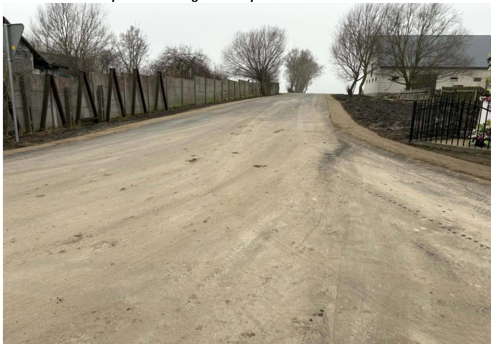
Zdjęcie 6. Przebudowa skrzyżowania w Rogowie Starym
